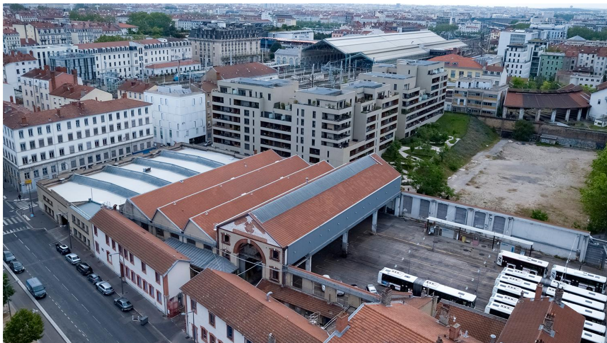
Usine Satre actuellement dépôt TCL (drone)
