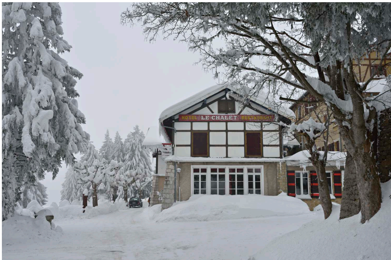
Vue d'ensemble depuis l'accès automobile (nord-est), sous la neige
