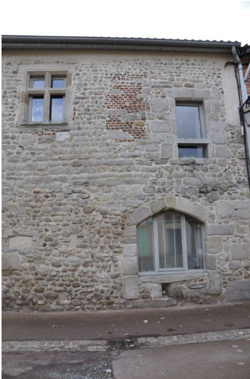
1986 AE 157, place de l'Eglise. Maison, détails ouvertures.
