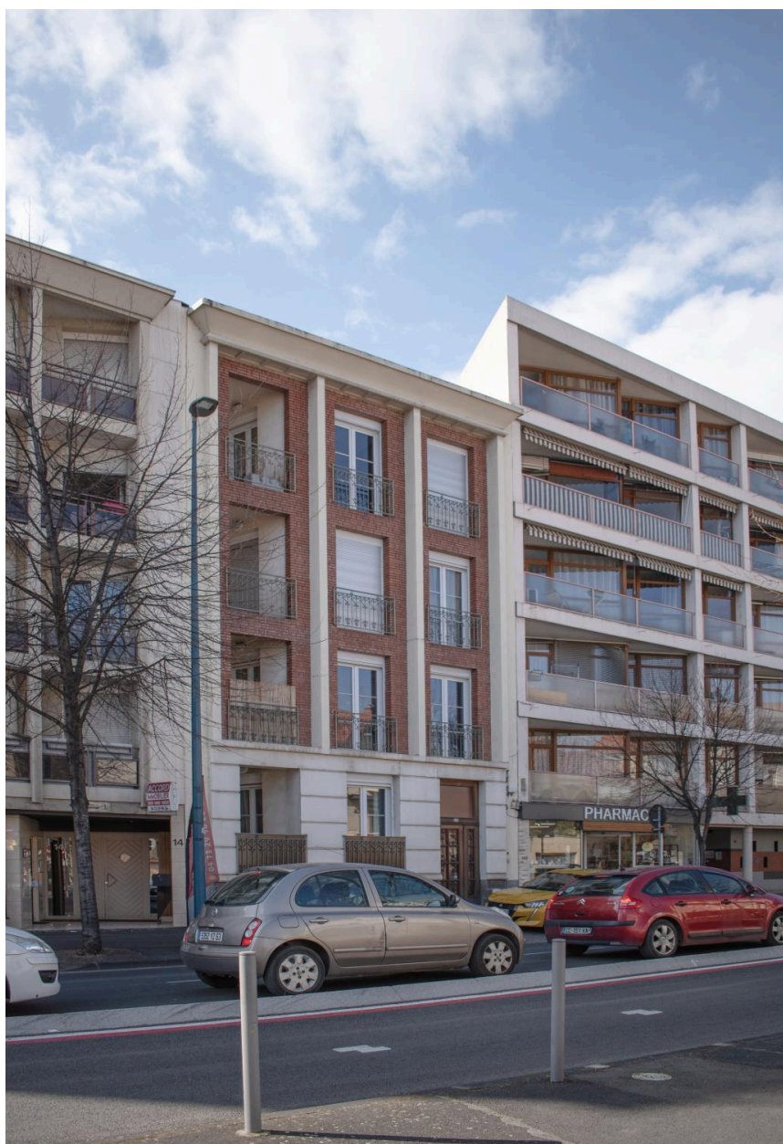
Façade sur le boulevard Aristide-Briand
