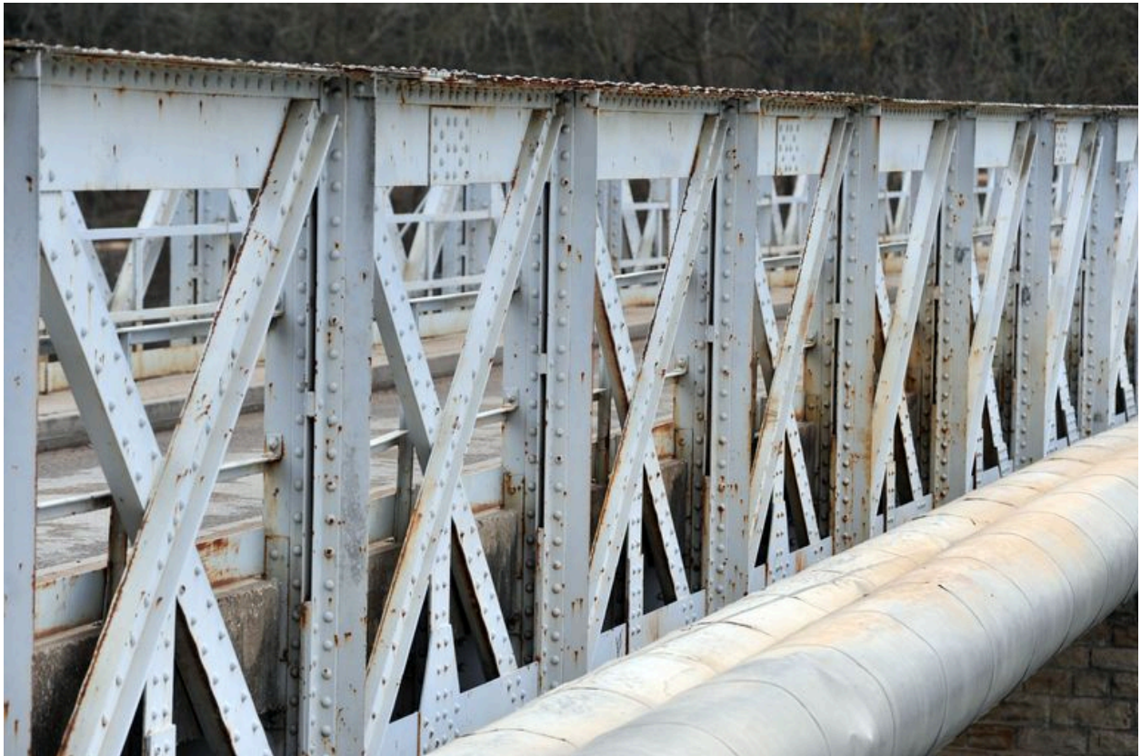
Tablier, face aval, vue partielle : structure métallique (depuis la rive droite)
