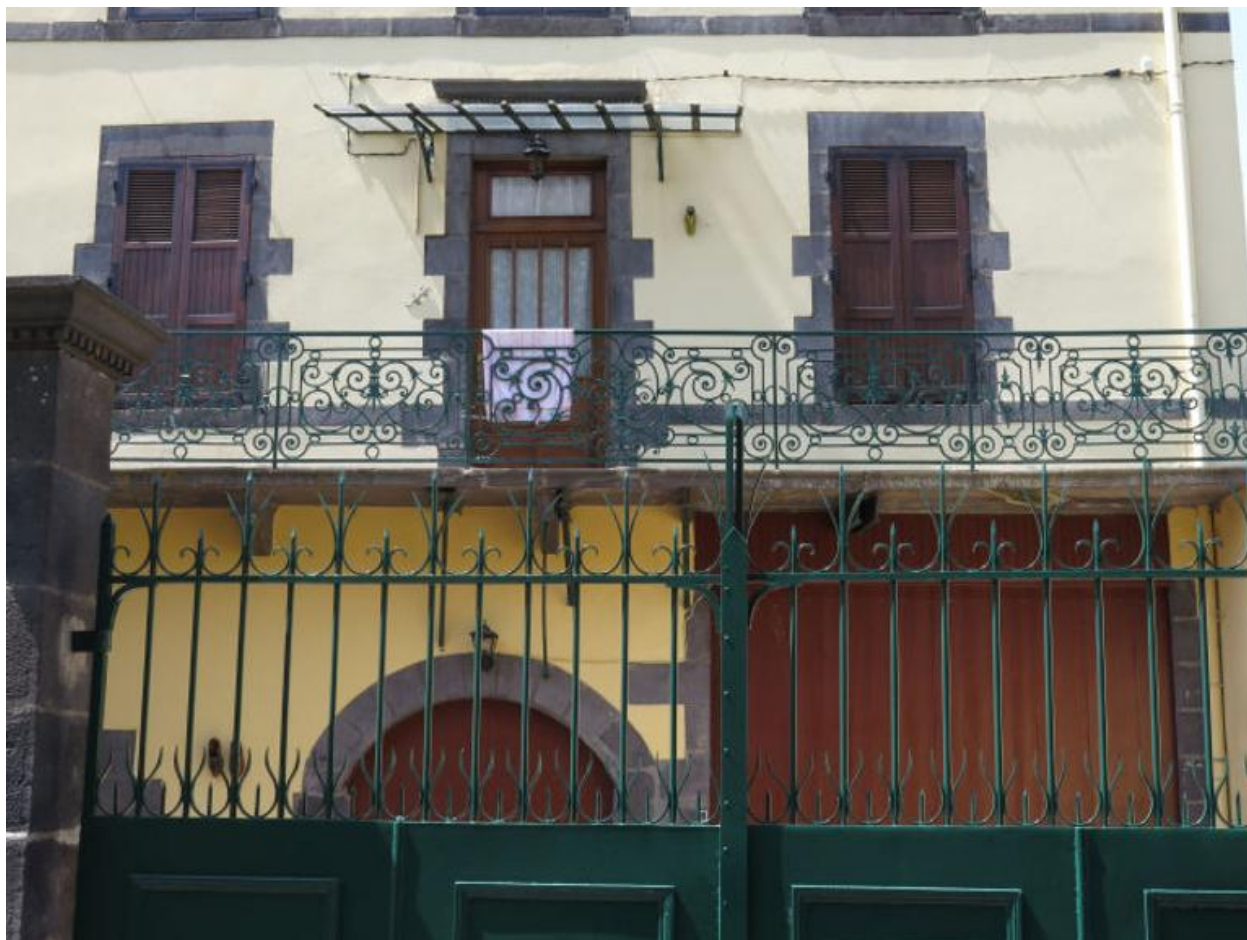
Vue partielle de la façade
