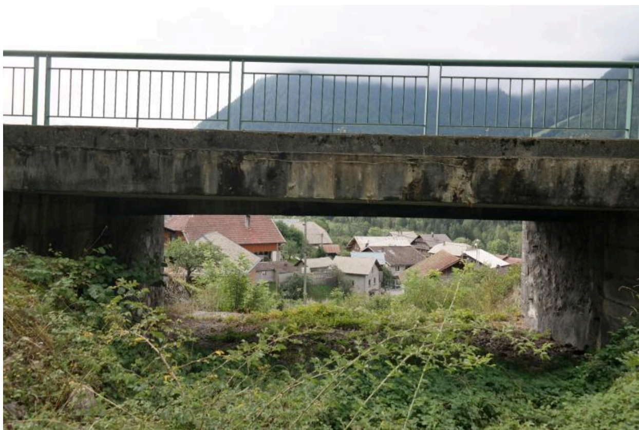
Pont du Fontanil, vue de la face amont
