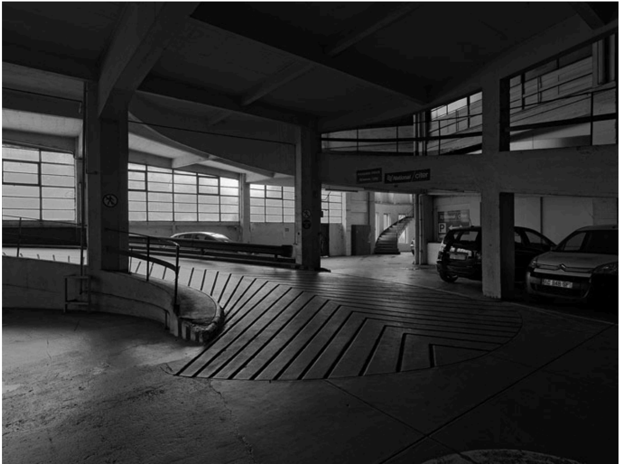
Départ de la rampe montante
