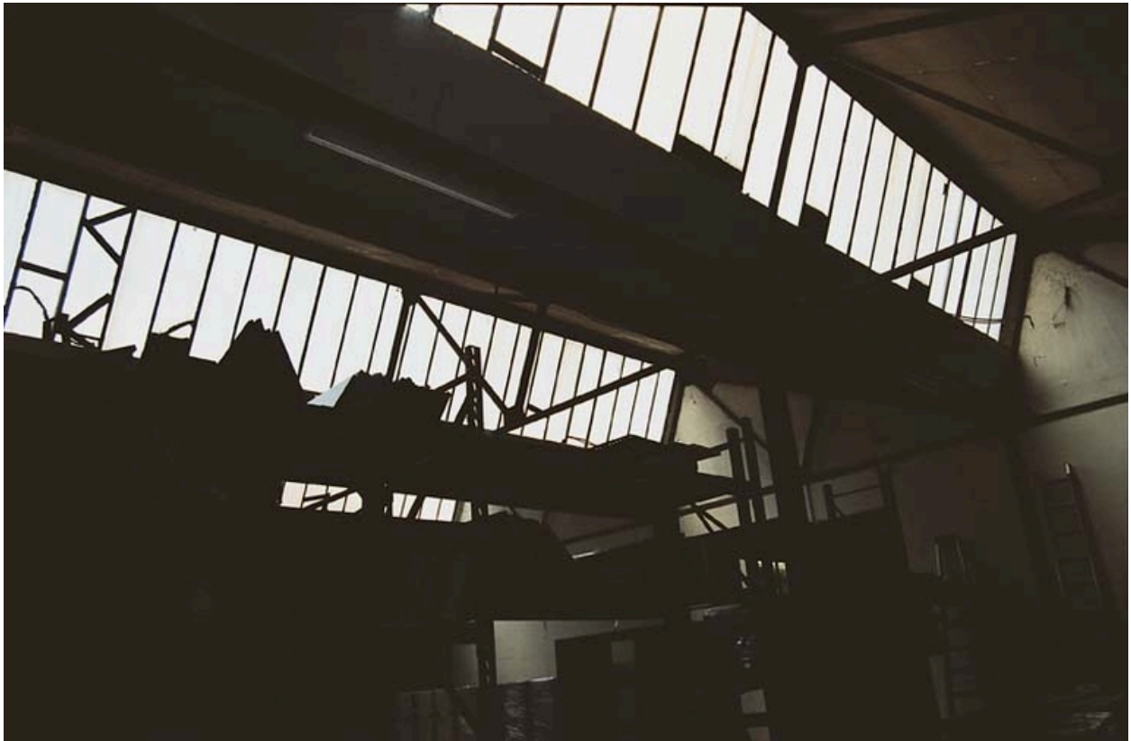
Vue intérieure, sheds
