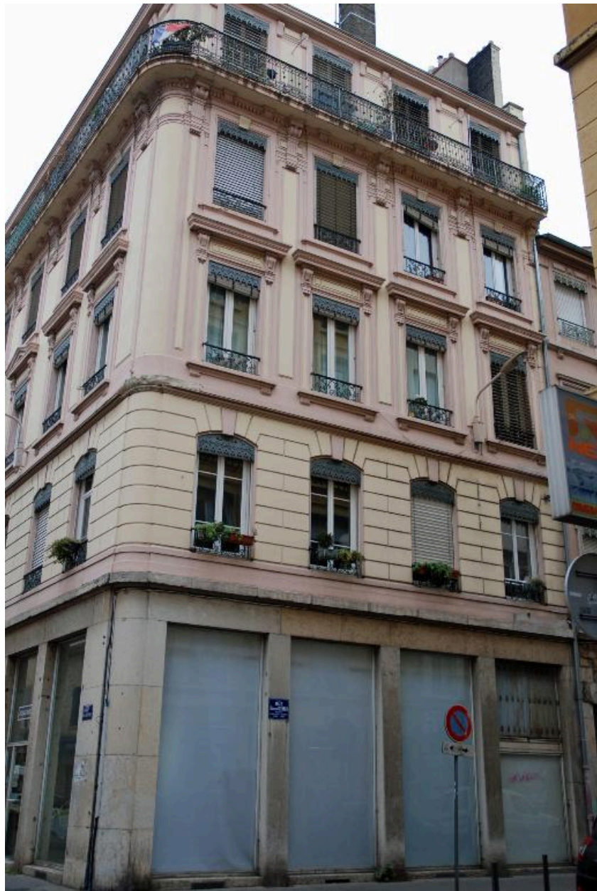
Elévation sud, rue Salomon-Reinach
