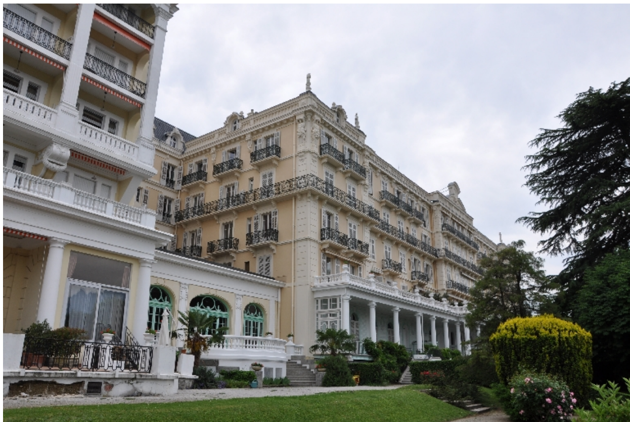
Façade ouest vue de trois-quart gauche
