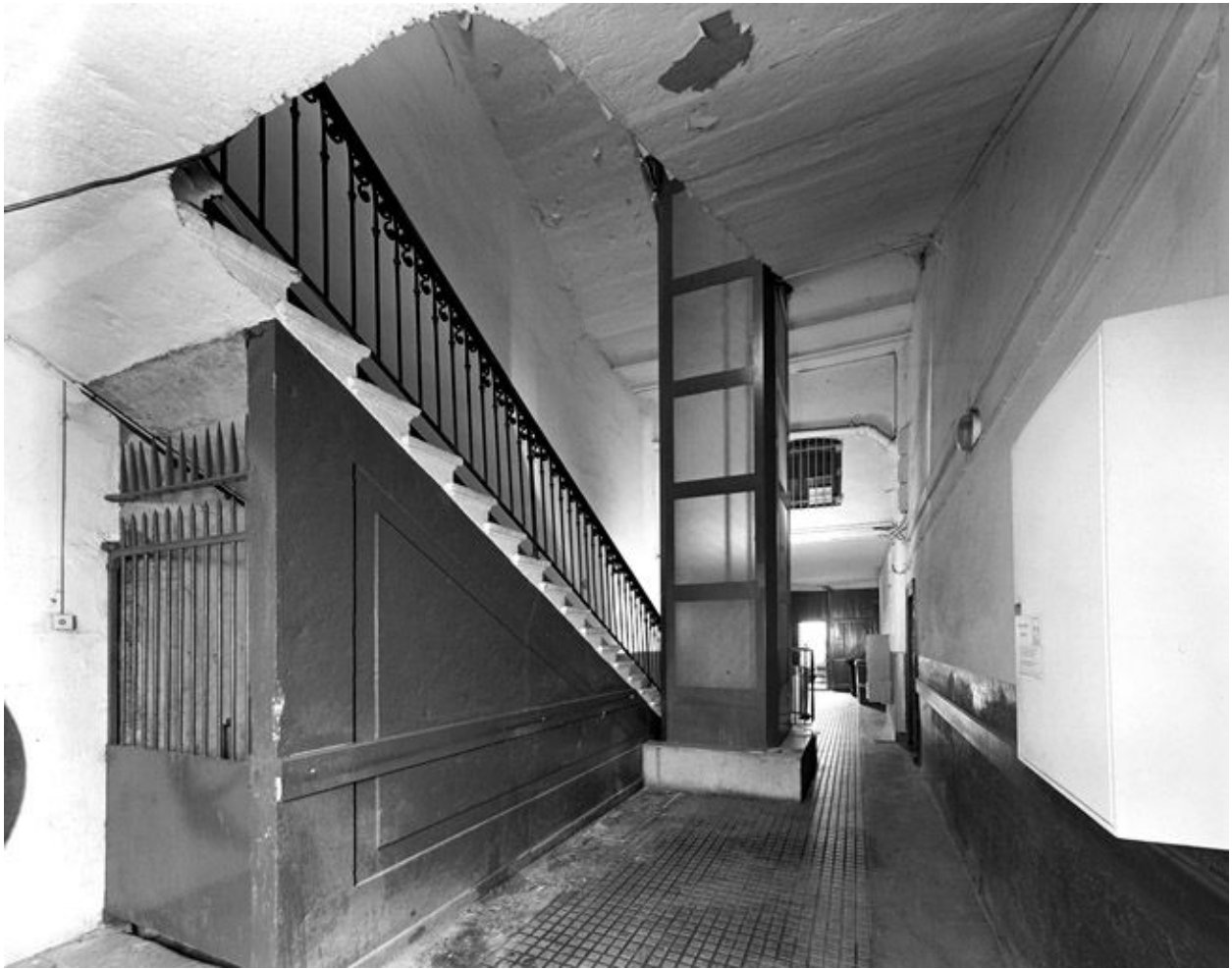
Vue du vestibule et de l'escalier depuis le fond de l'immeuble
