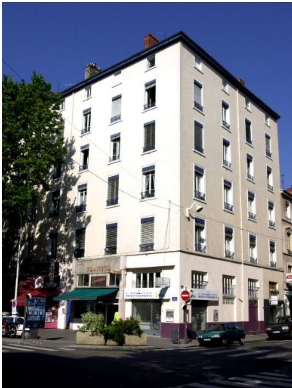
Vue d'ensemble, angle du cours Charlemagne et de la rue Bichat
