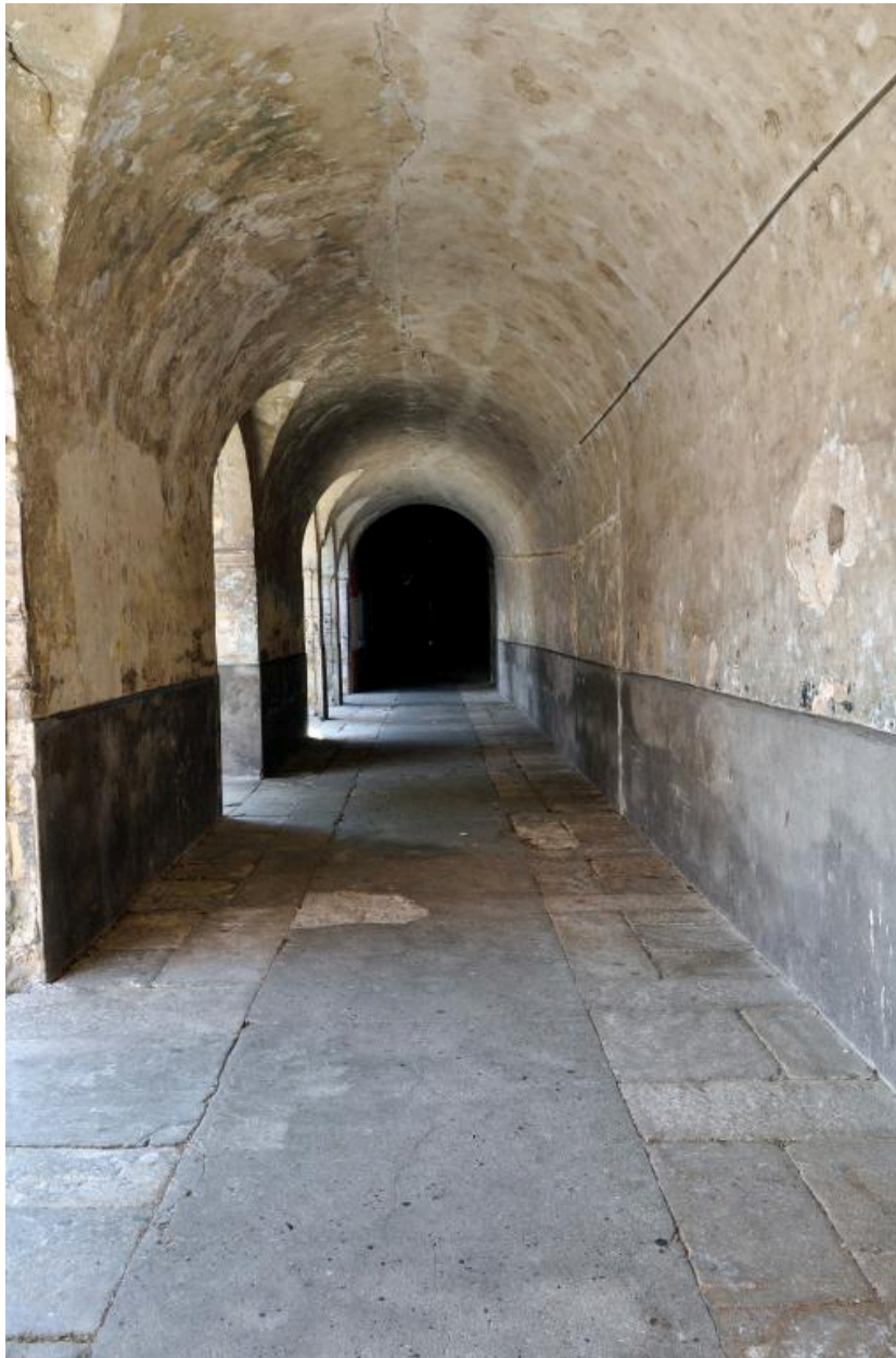
Bâtiment B : portique, depuis l'est
