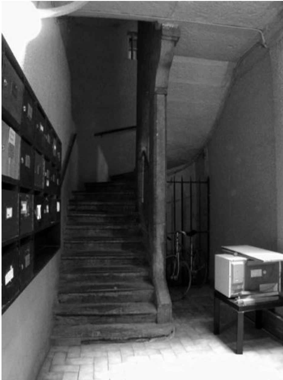
Escalier vu depuis la cour
