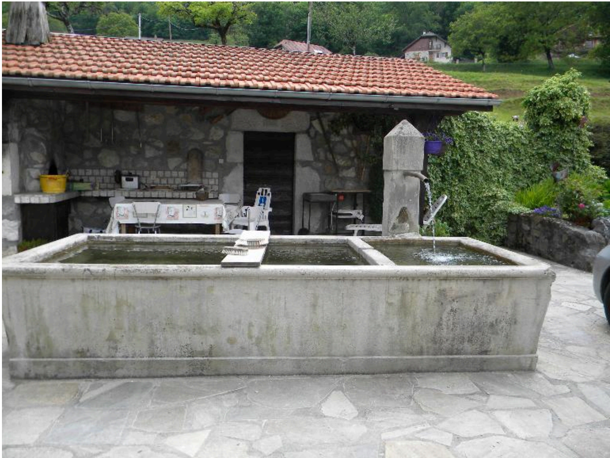
Vue du bassin de face.
