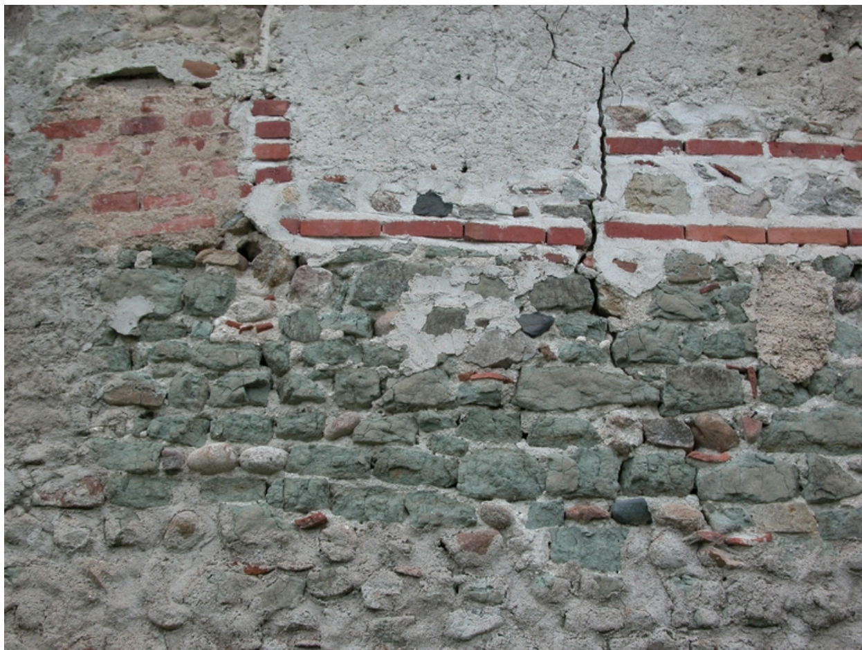
Détail de matériaux du cellier.
