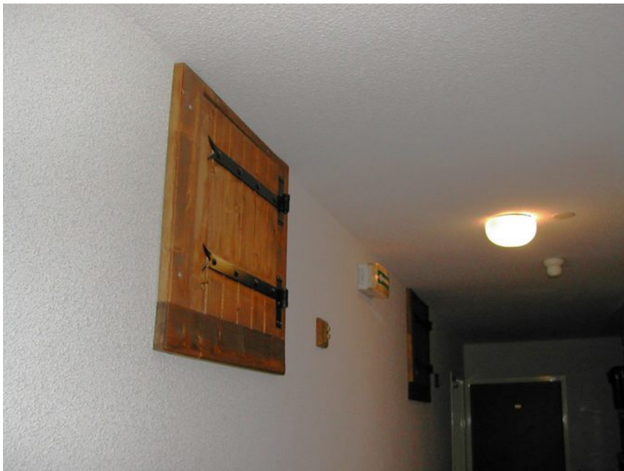
Fenêtre de second jour ouvrant sur le couloir de distribution des appartements
