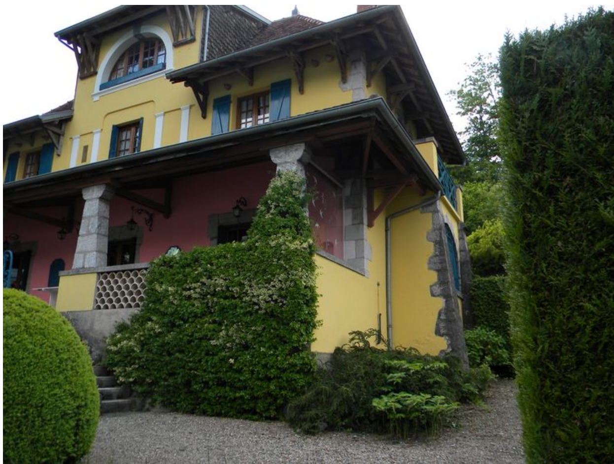
Vue de la partie nord de la façade est depuis la cour.
