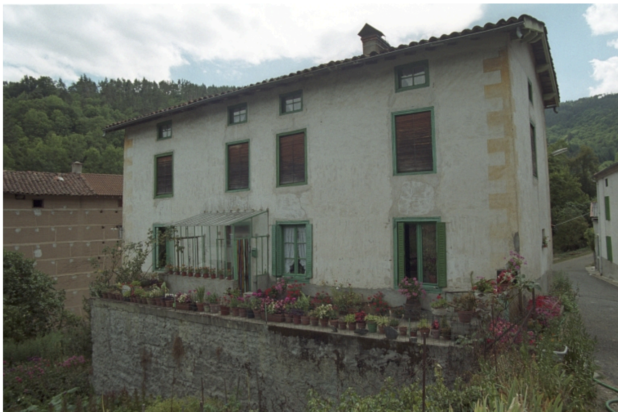
Praval, ferme, vue d'ensemble du logis (1986 B1 117, 118, 1247).
