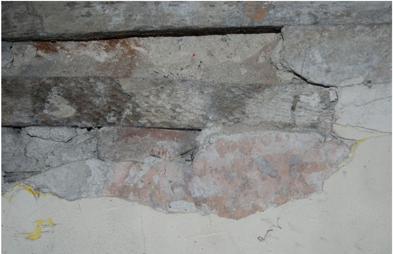
Détail de la mise en oeuvre et des enduits dans la montée d'escalier.
