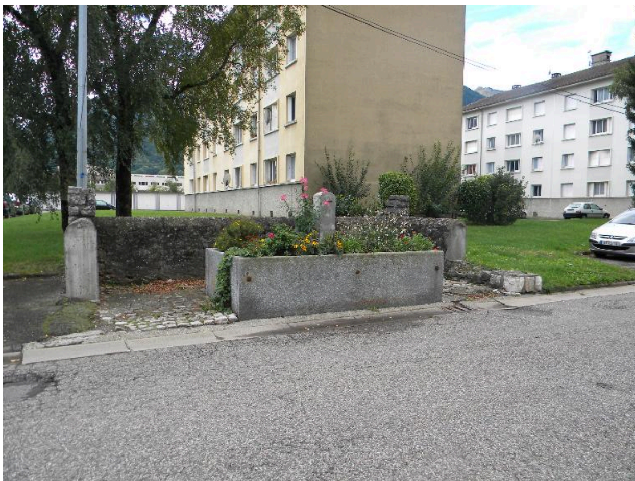
Vue d'ensemble du bassin
