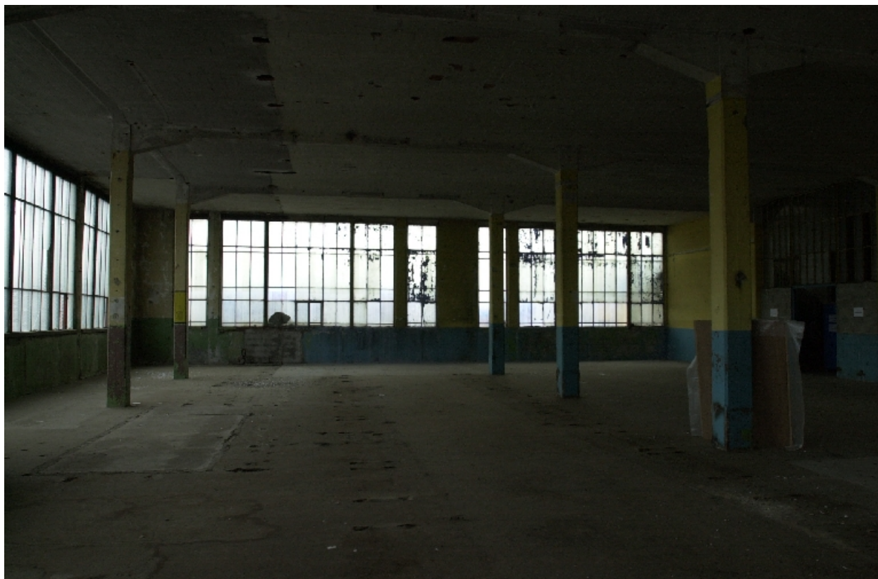
Vue intérieure des ateliers, baies rectangulaires
