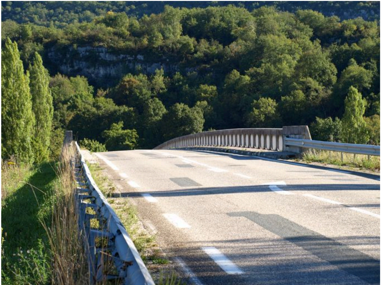
Chaussée (depuis la rive gauche)
