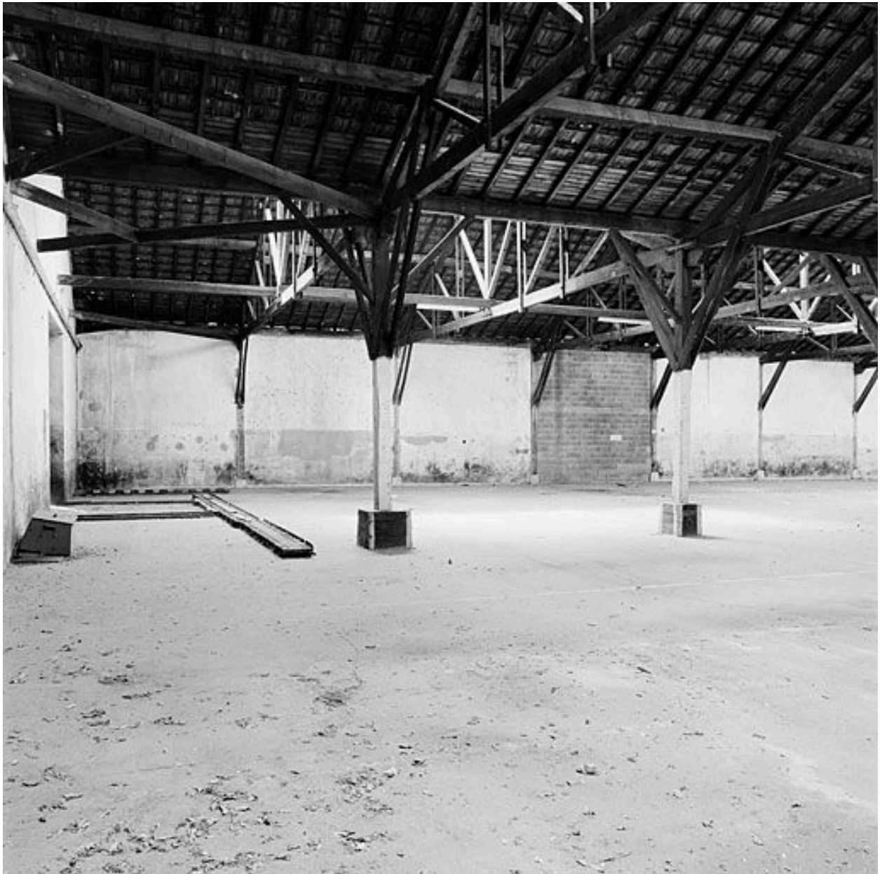
Entrepôts: bâtiment 2 vue intérieure
