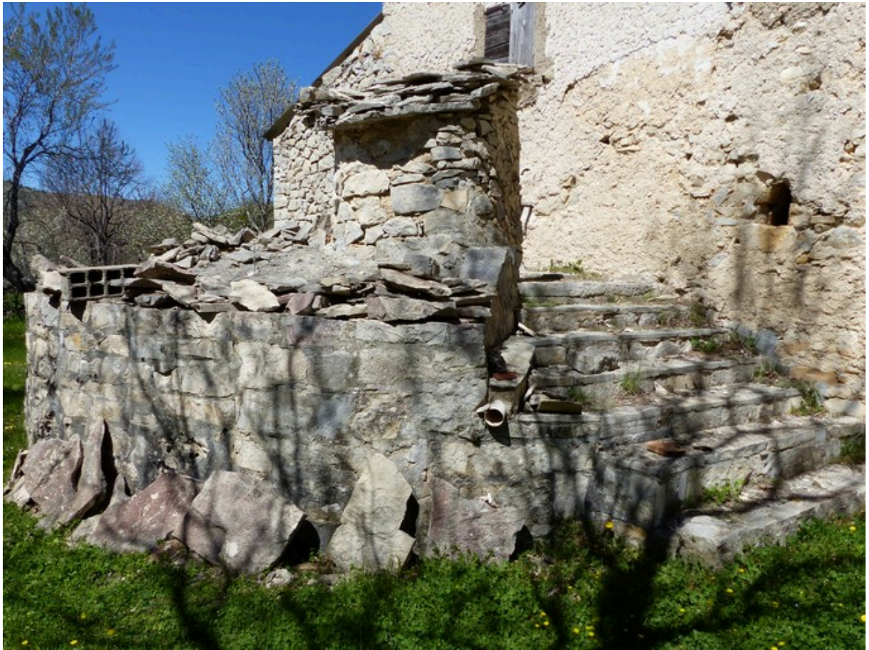
Pignon ouest, citerne. Vue d'ensemble prise du sud-ouest.
