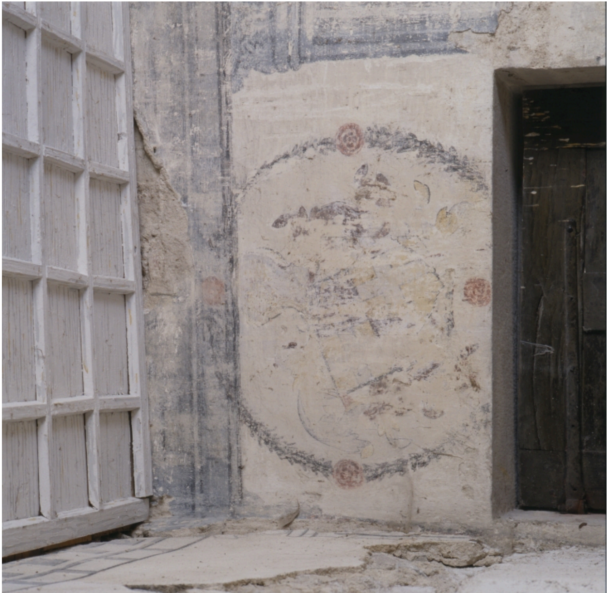
Mur nord-est, décor d'armoiries au-dessus de la porte.
