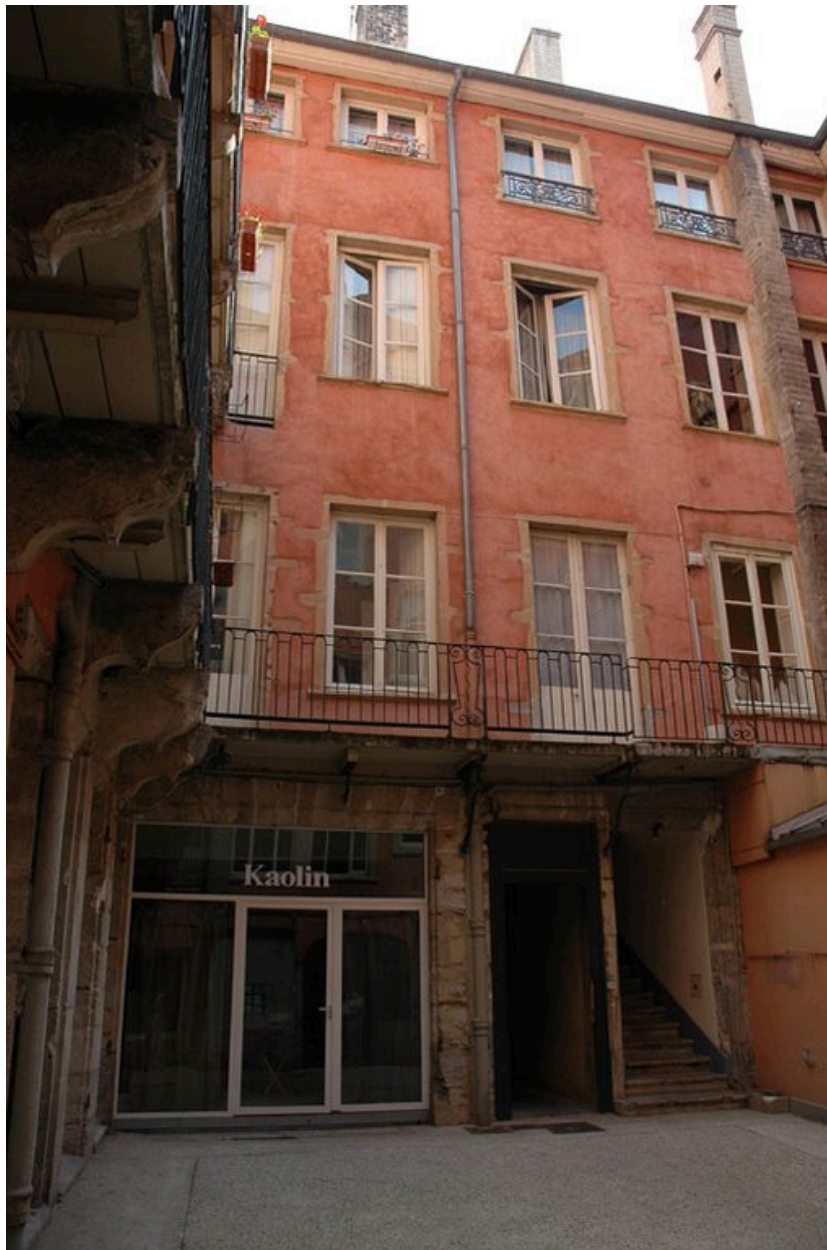
Elévation nord de la cour
