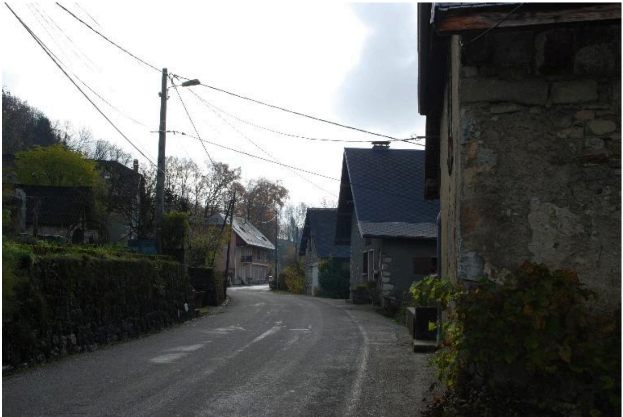
Vue générale intérieure du village vers le sud Chef-lieu, RD n° 49. Ferme n° 2014 B3 279 au premier plan à droite
