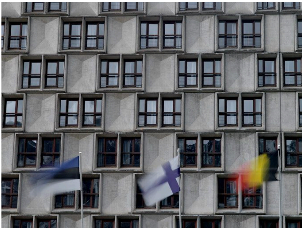
Détail des baies et des panneaux de béton moulé de la façade principale
