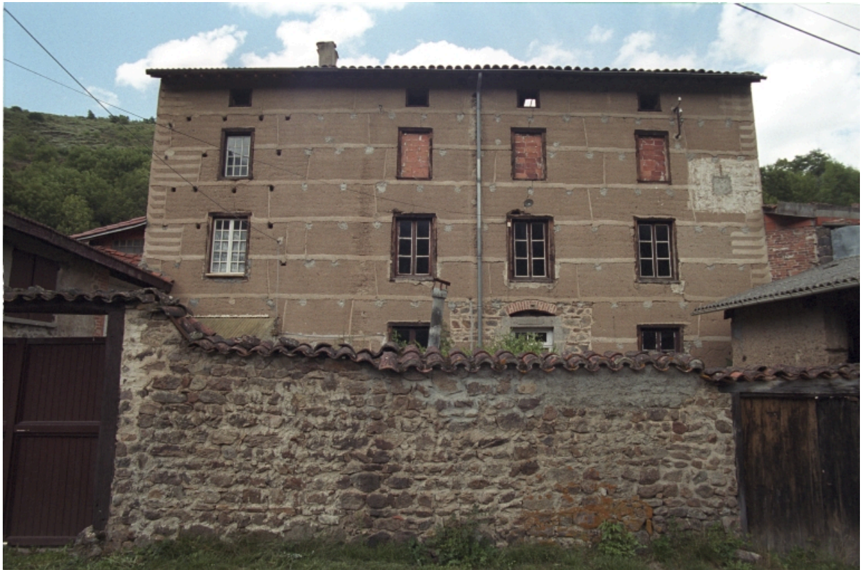
Praval, ferme, vue d'ensemble avant du logis (1986 B1 121, 122).
