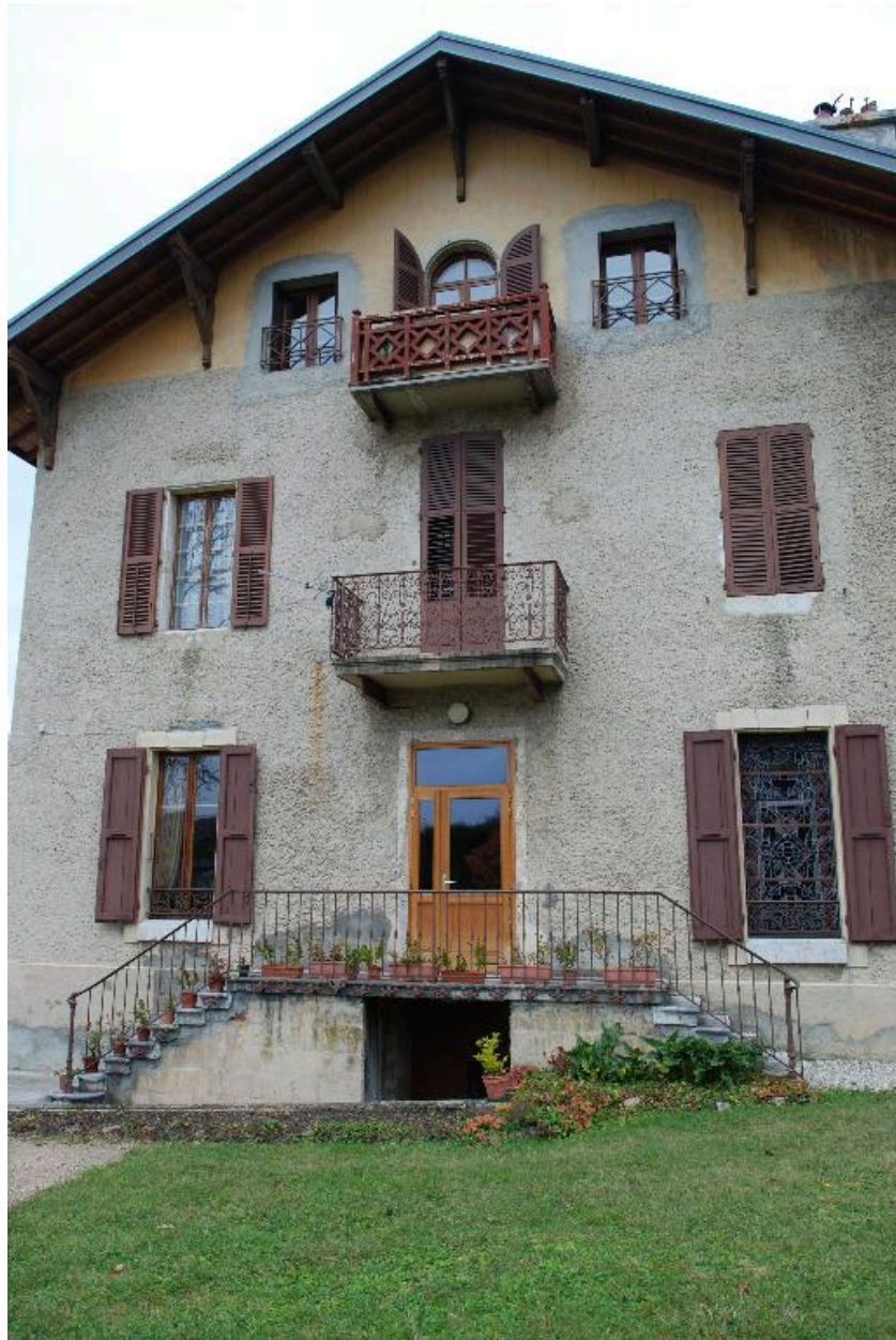
Vue d'ensemble du mur pignon sud.
