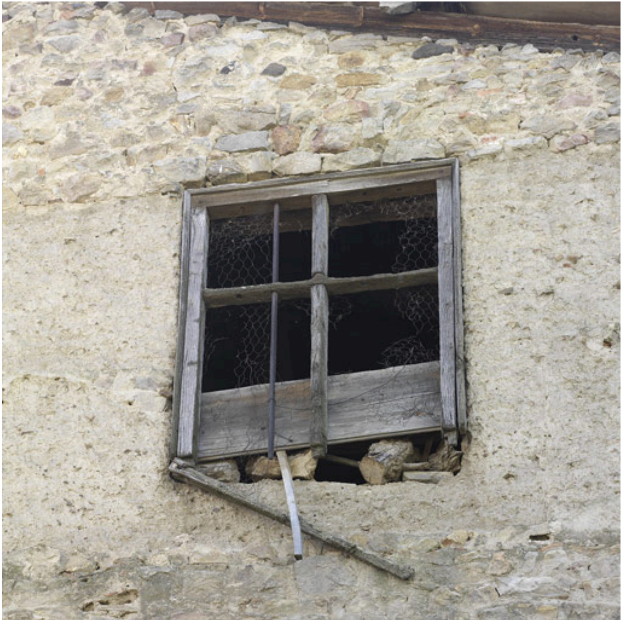
Détail de la fenêtre à meneau du pignon est du bâtiment nord-est.
