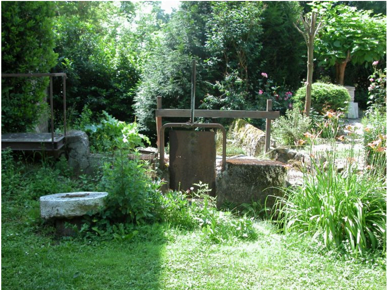
Vue d'ensemble du système de circulation d'eau avec la vanne de régulation du trop plein.
