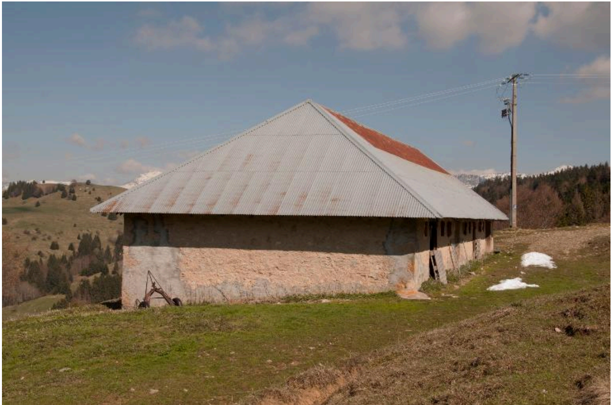
Vue de l'étable nord, depuis le sud-ouest.
