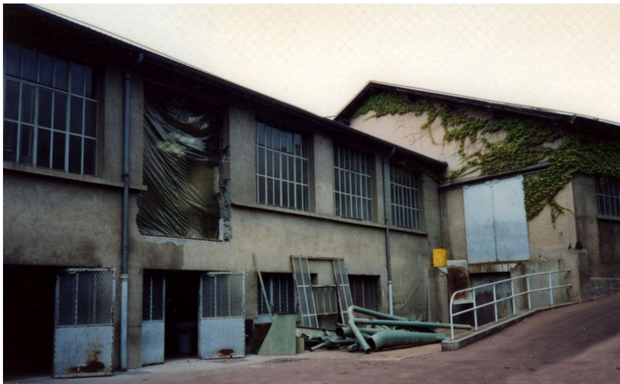
Vue de la modèlerie, au commencement des travaux, décembre 1992
