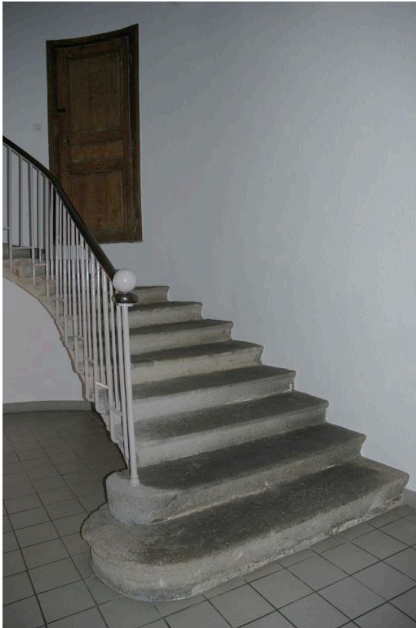
Départ d'escalier de l'immeuble sur le boulevard.
