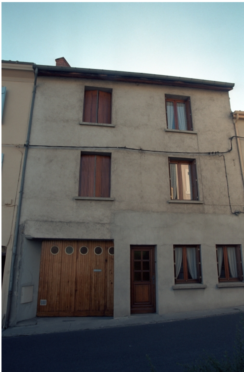
Boën, îlot 16, 8 Mai 1945 (rue du) 17. Vue générale de la façade sur rue.
