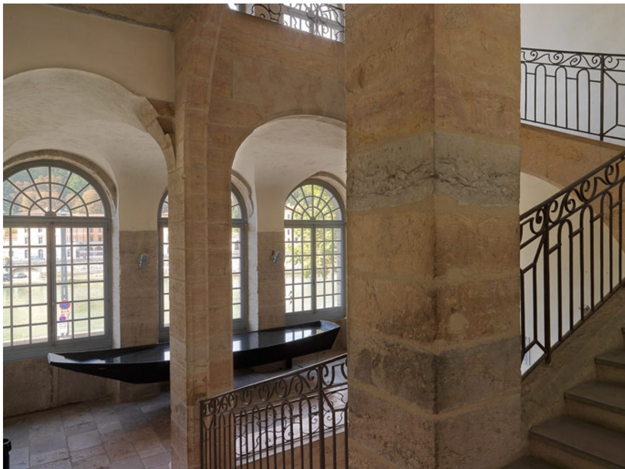
Escalier axial classé MH.
