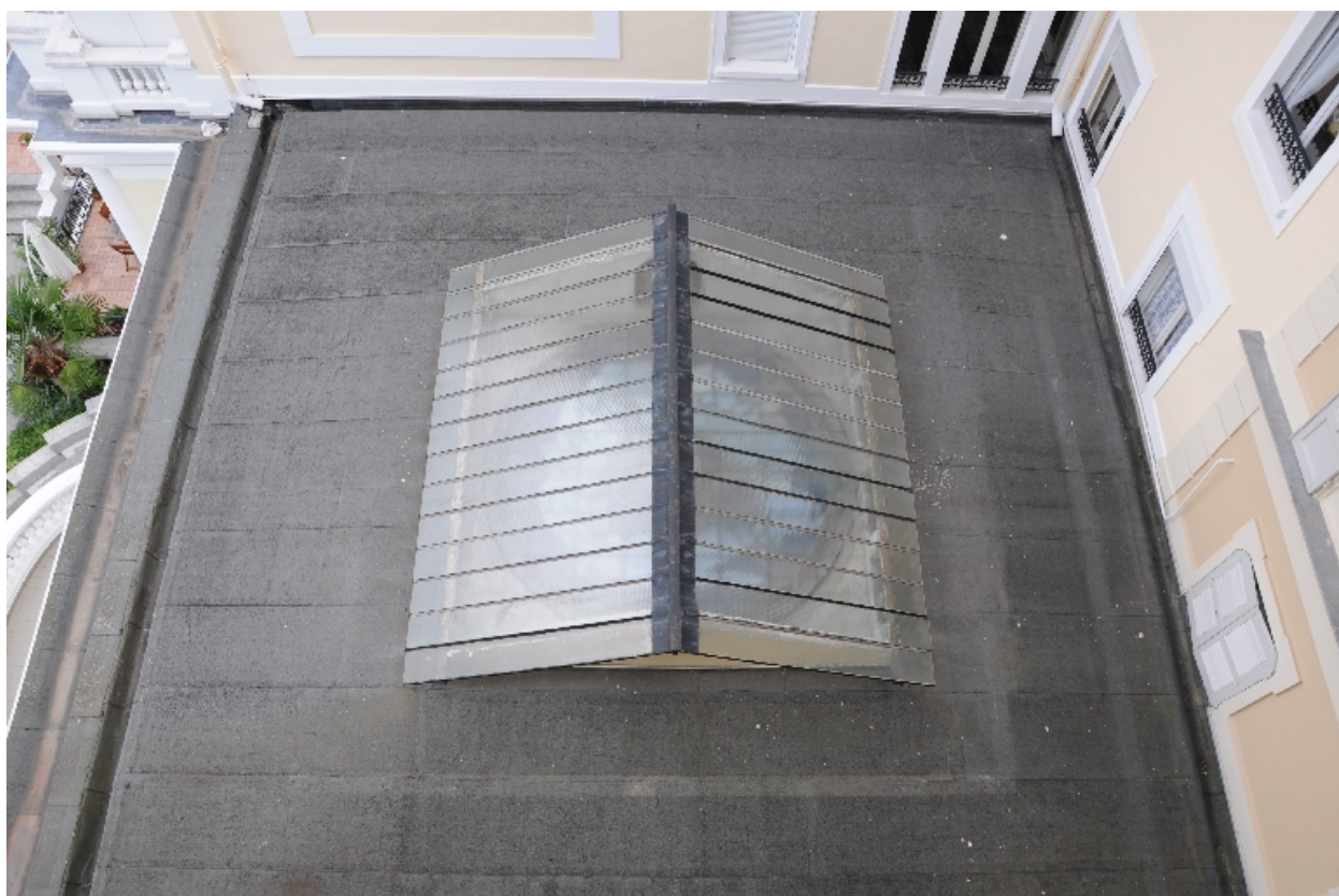
Toit du hall
