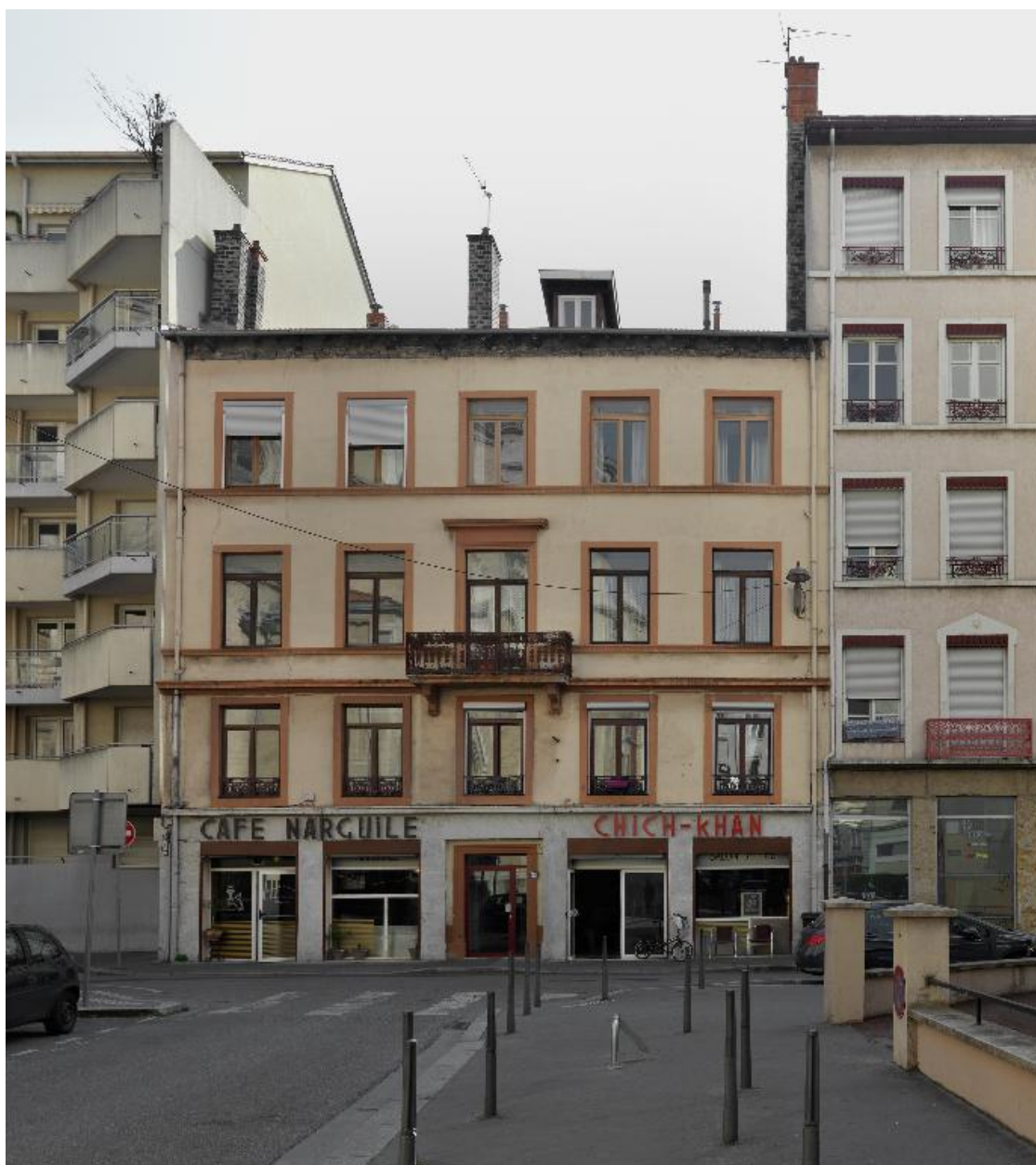
Vue générale, élévation sur rue
