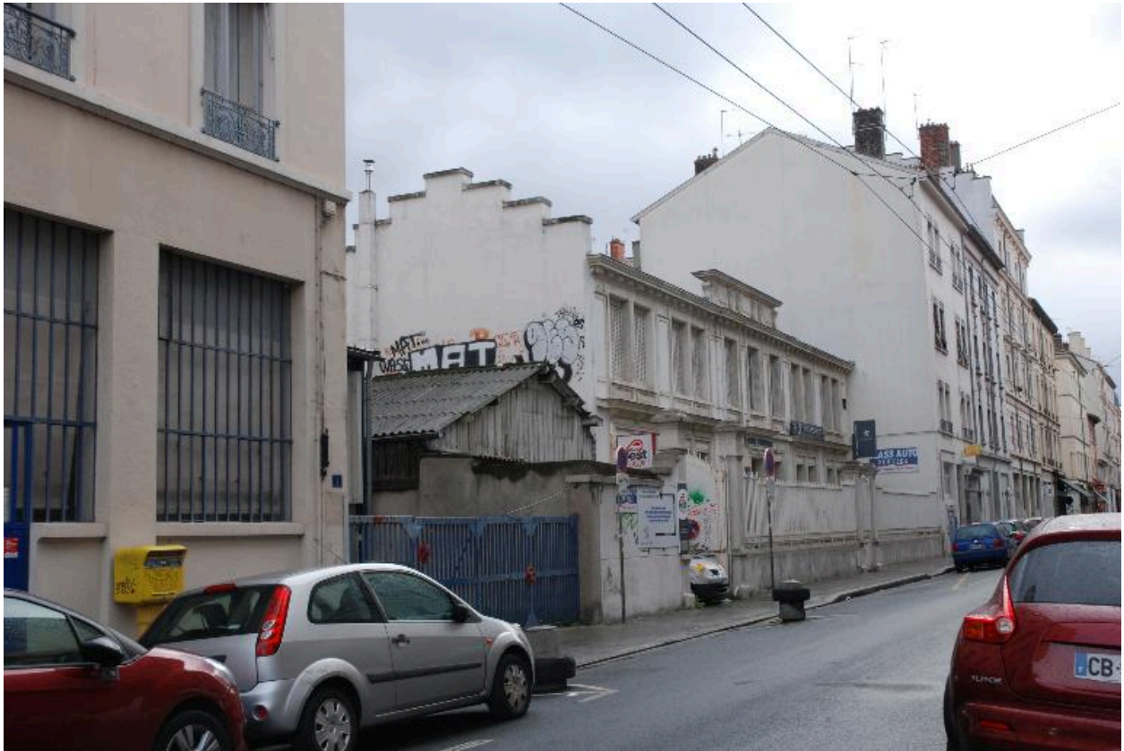
Vue d'ensemble nord-ouest
