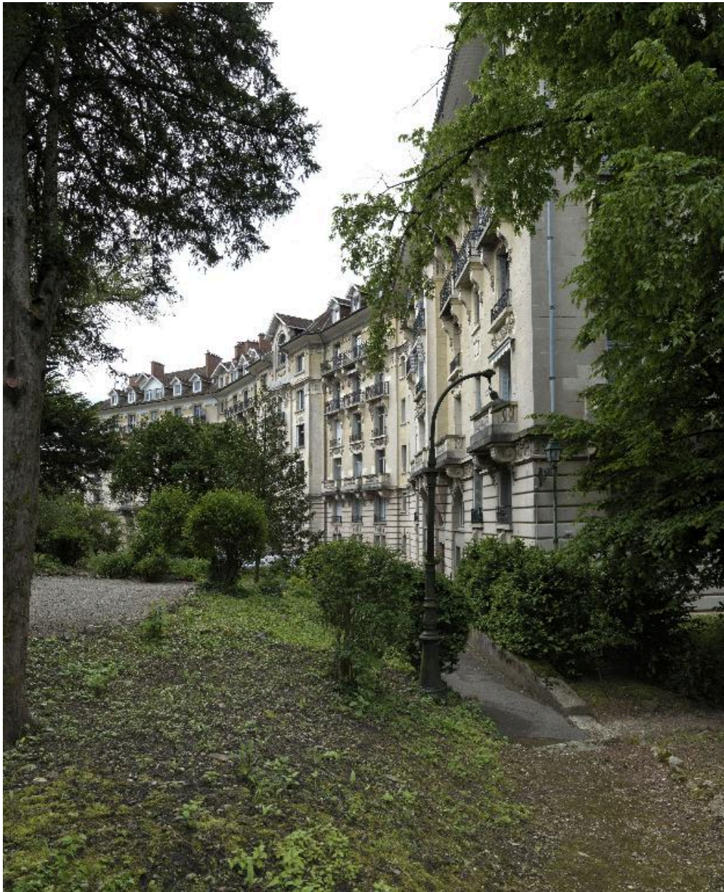
Façade sur cour: vue d'ensemble depuis le nord
