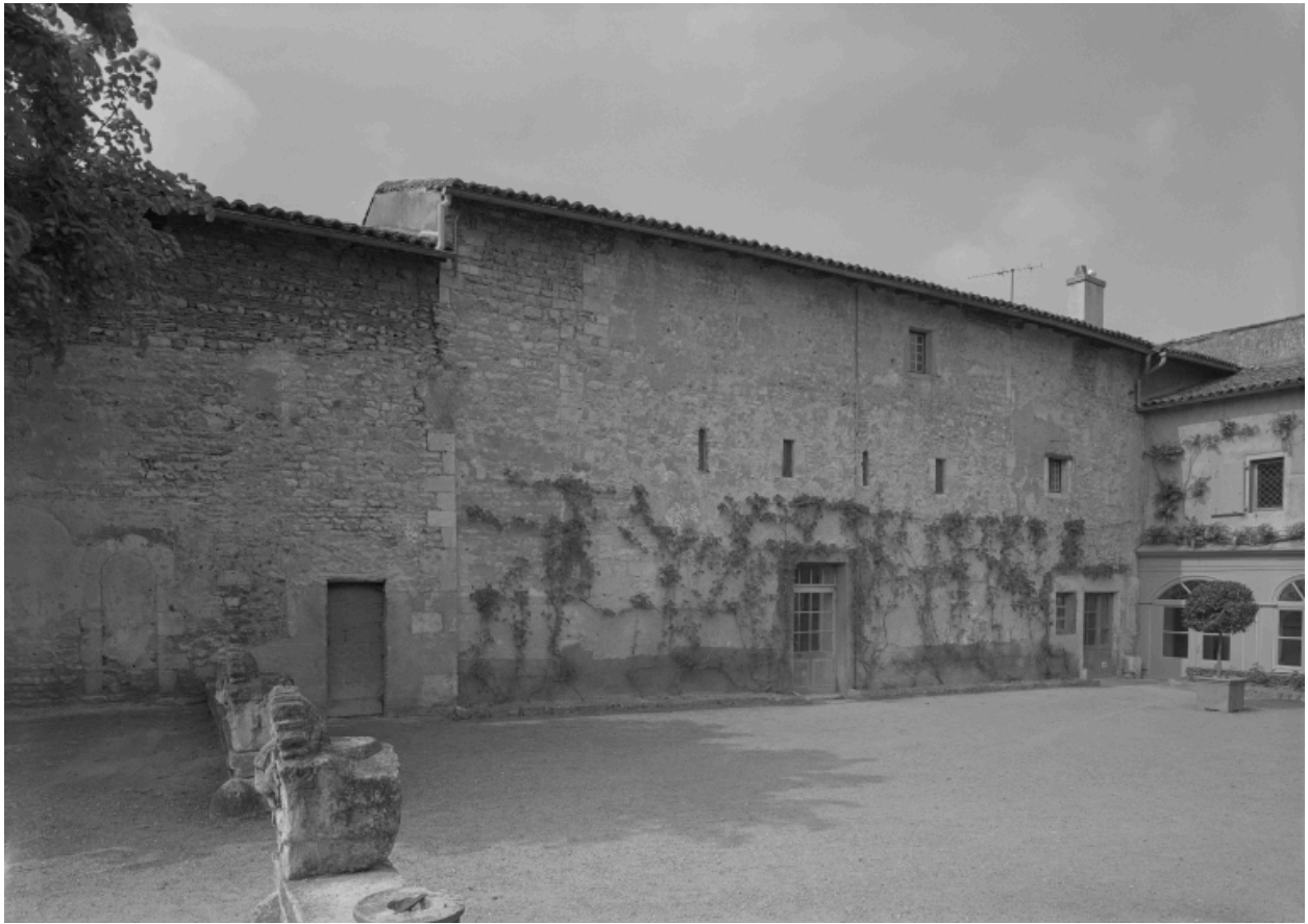
Aile gauche, élévation sur cour.
