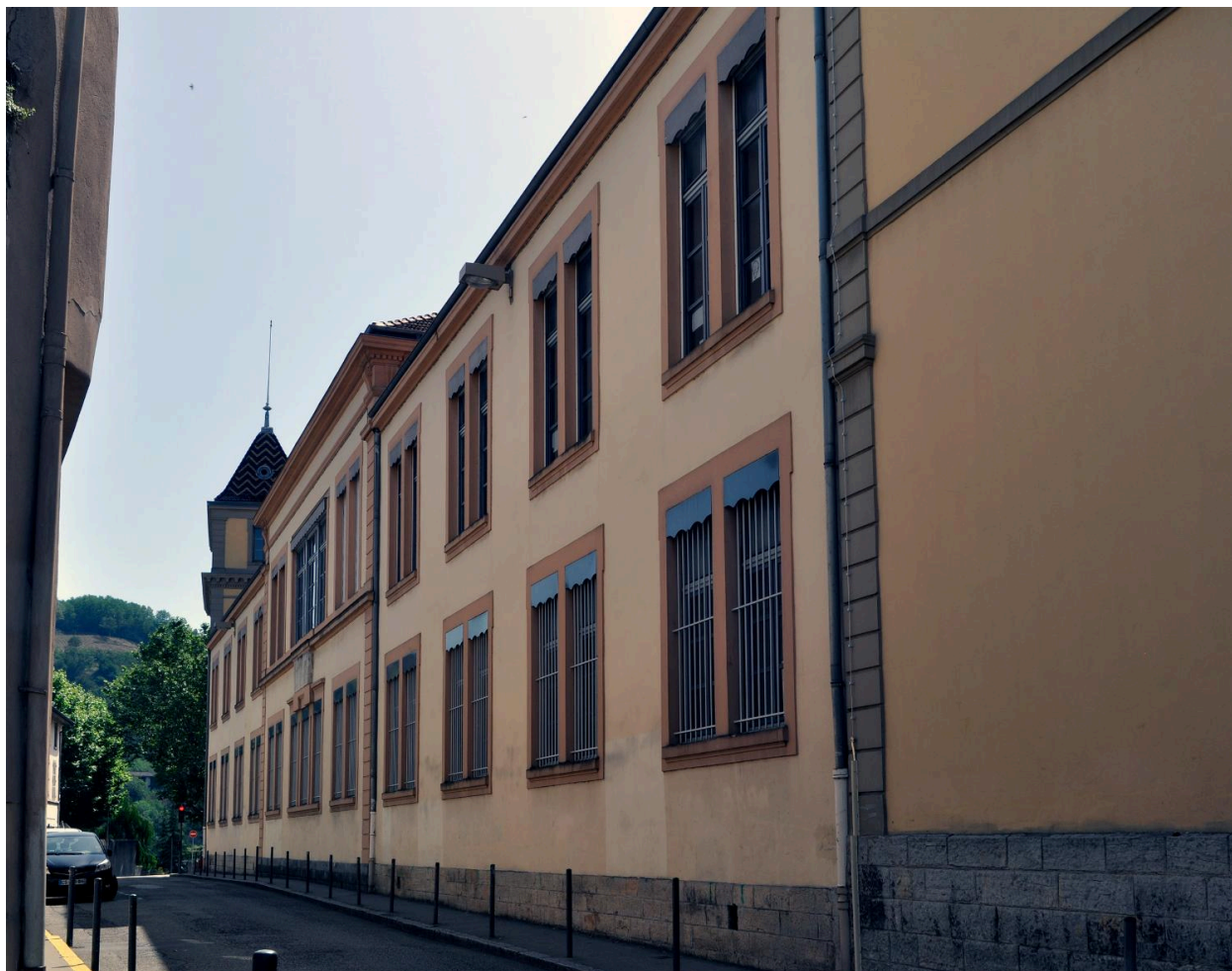
Élévation latérale nord, depuis l'ouest
