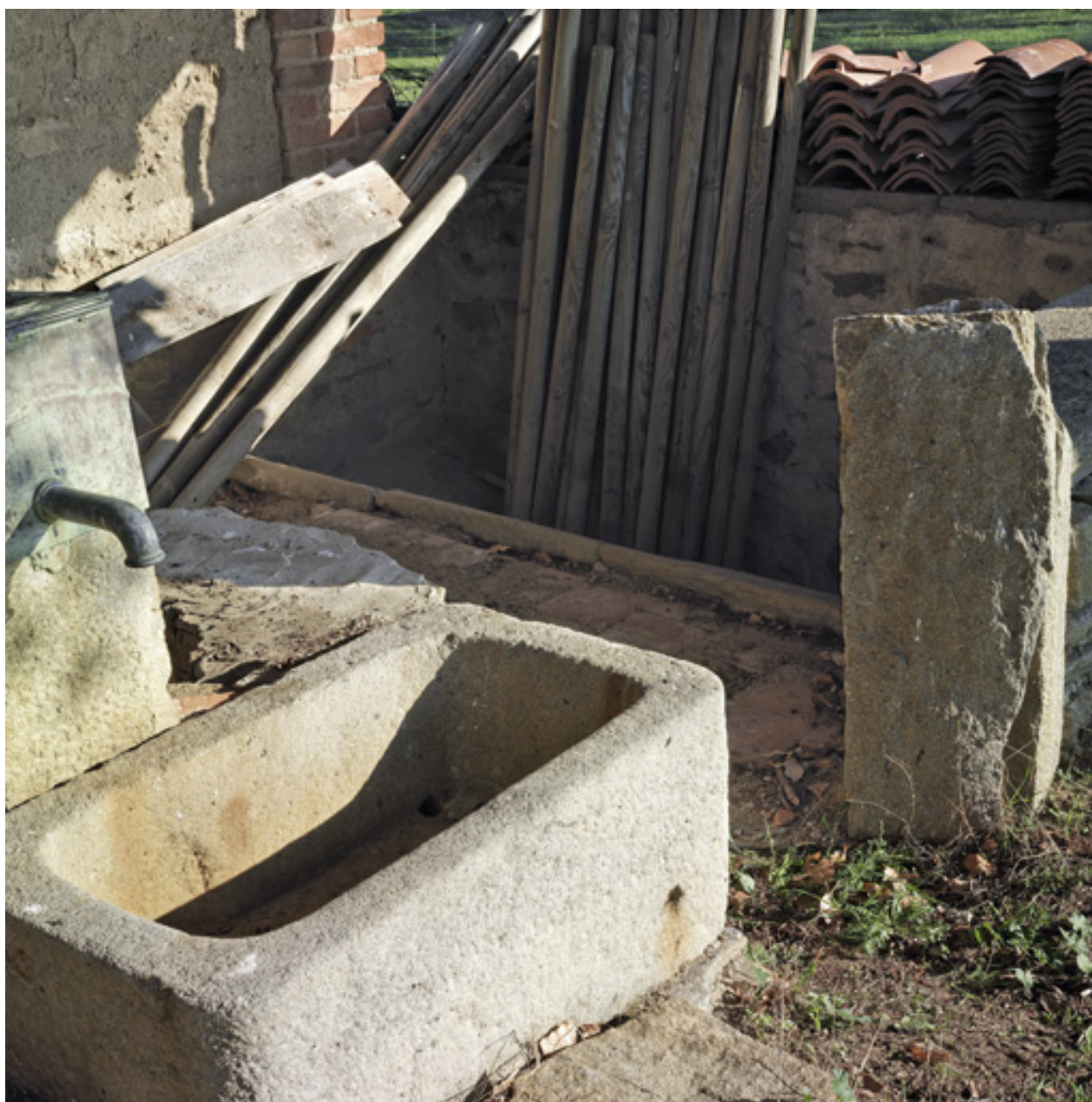
Vue intérieure du lavoir-abreuvoir.
