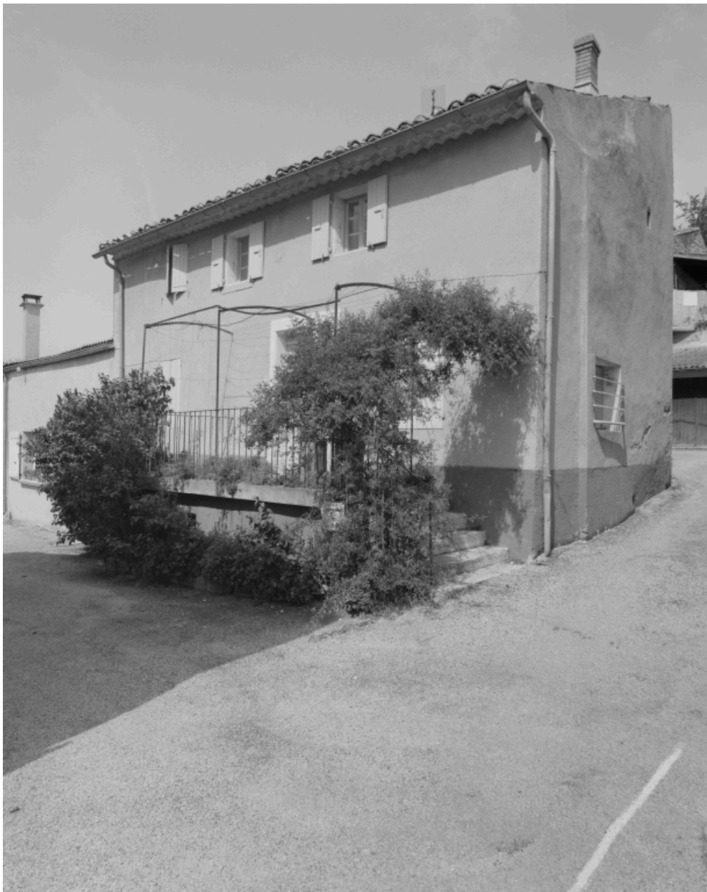
Elévation principale de la maison (B1 288).
