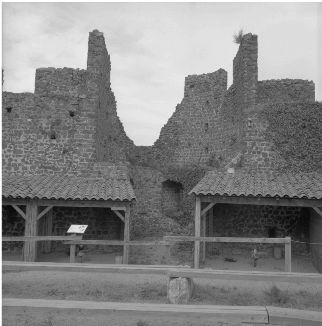
Vue intérieure de la tour nord-ouest de l'enceinte, depuis l'est.
