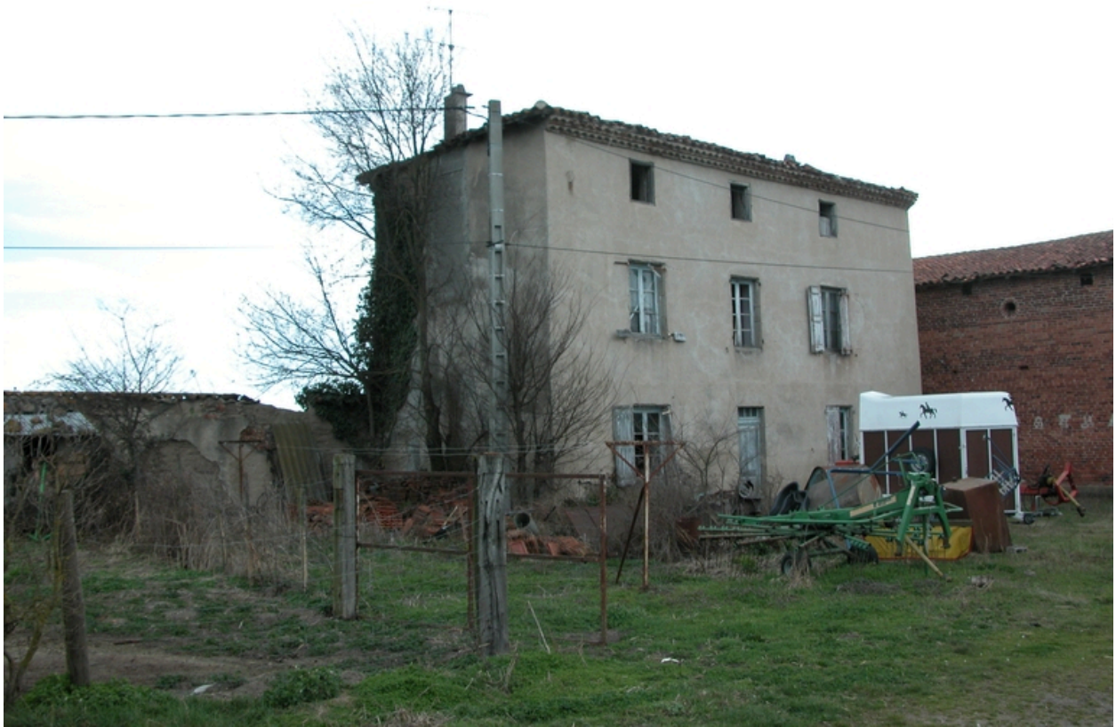
Vue d'ensemble du logis 1, depuis l'ouest.
