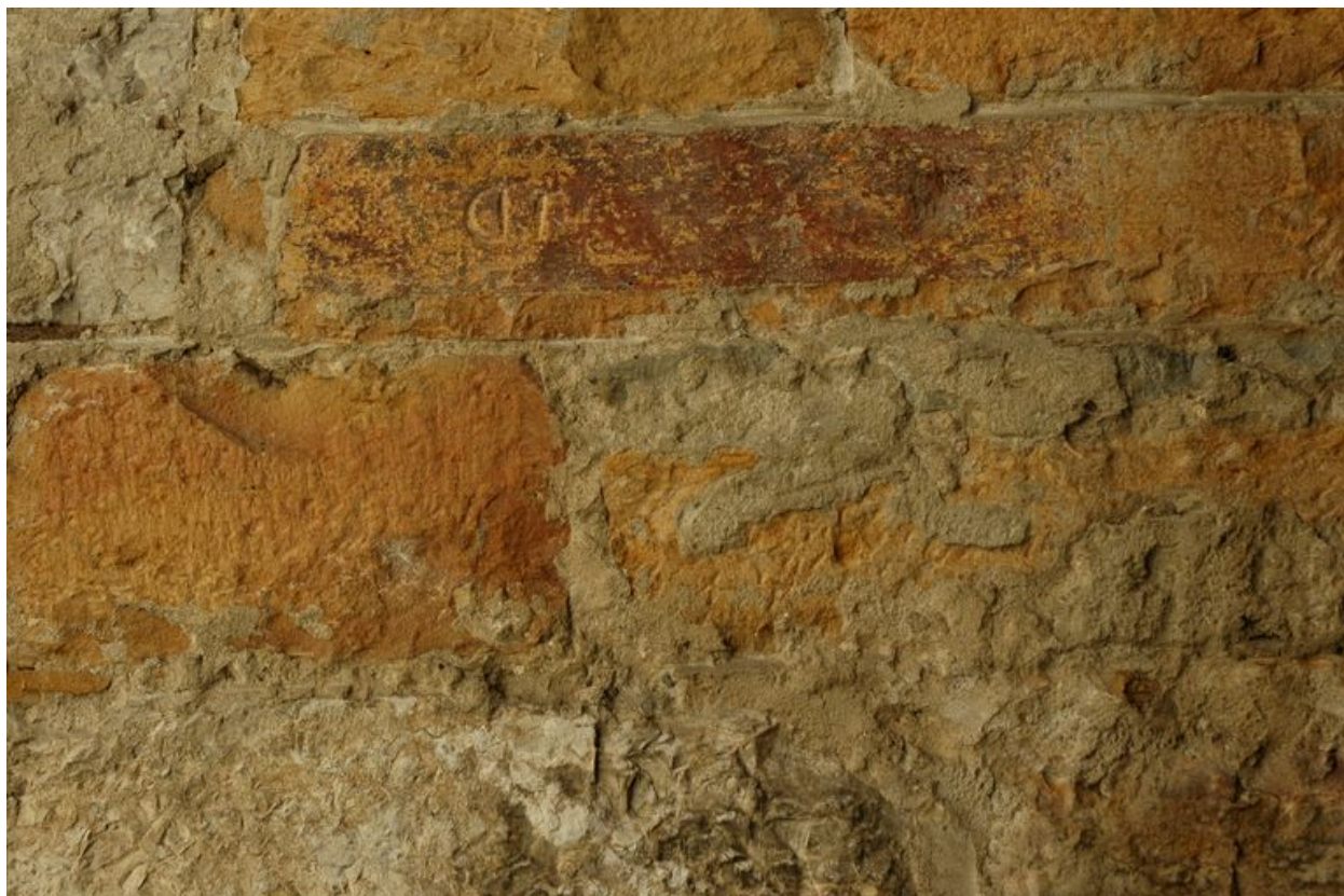
Détail de l'appareillage du mur ouest avec marque de tâcheron ID
